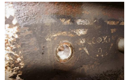
Штепсель соединителя втулочного и отверстие в рельсе после 28 месяцев эксплуатации (следов ржавчины практически нет)
