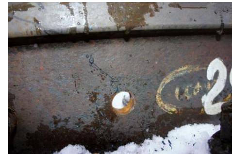
Штепсель типового соединителя и отверстие в рельсе со следами ржавчины
